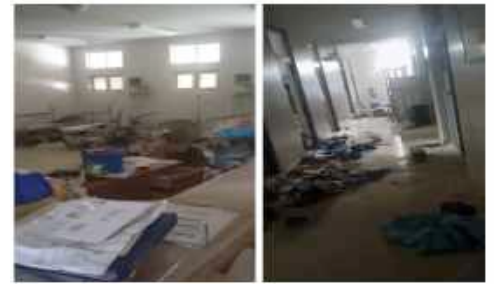
Fig. 2 et 3 : Photo bloc opératoire-salle de réveil de l'Hôpital Saint-François de Sales
